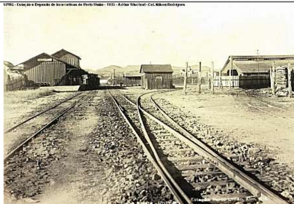
FIGURA 4: VISTA DAS DUAS ESTAÇÕES FERROVIÁRIAS ADJACENTES
