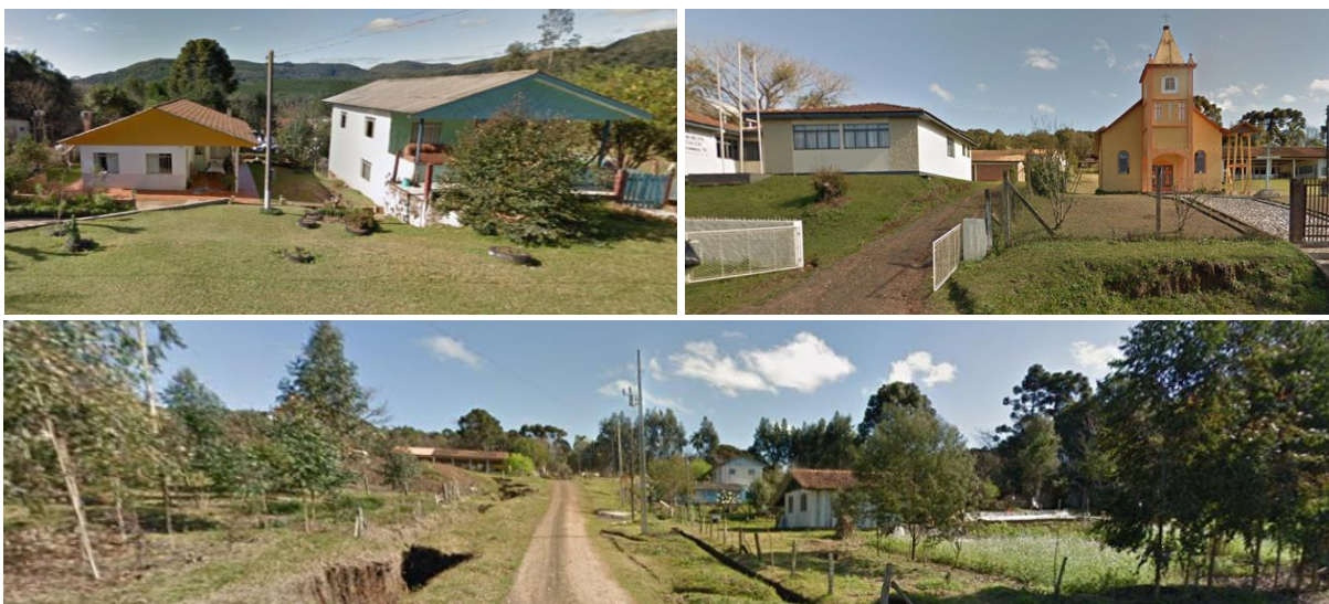
FIGURA 25: VISTAS DA SEDE DO DISTRITO SÃO DOMINGOS
