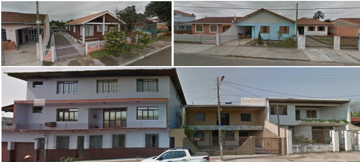
FIGURA 15: VISTAS DA ZONA URBANA DE MÉDIA DENSIDADE
