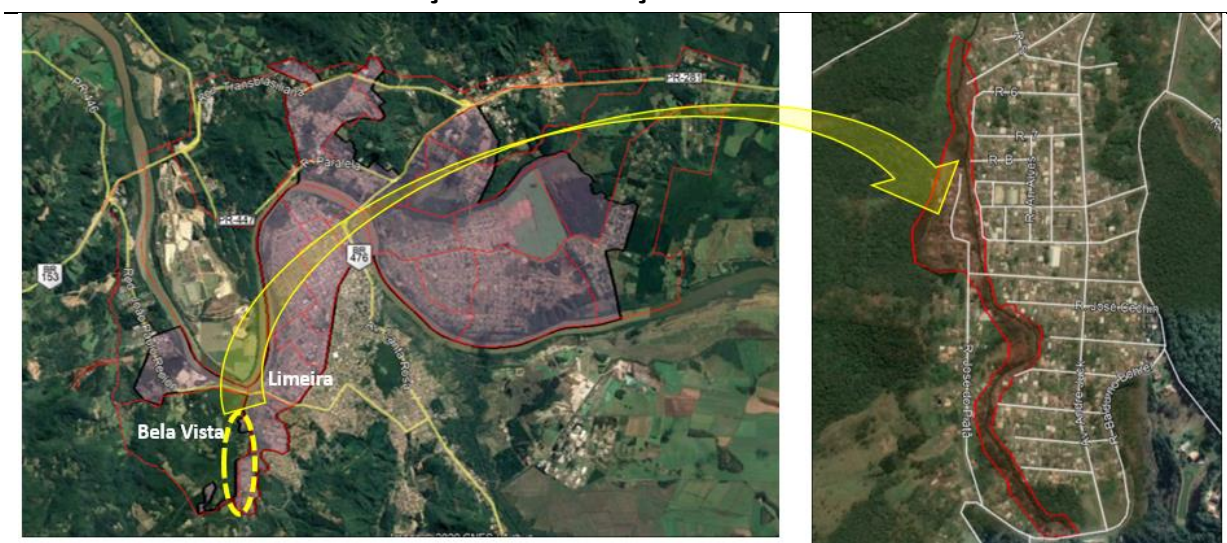
FIGURA 20: LOCALIZAÇÃO DA OCUPAÇÃO IRREGULAR LIMEIRA PARTE I
