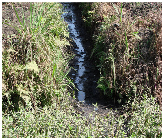
Figura 27 Vala de Drenagem Pluvial no Bairro Sagrada Família
