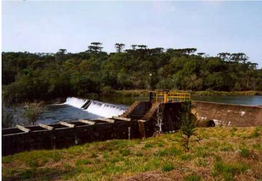
Figura 21: Barragem da Usina Hidroelétrica Salto do Vau
