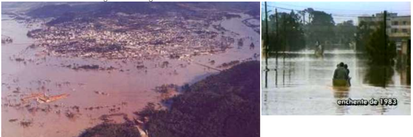
Figura 1: Imagens da Enchente em 1983 em União da Vitória
