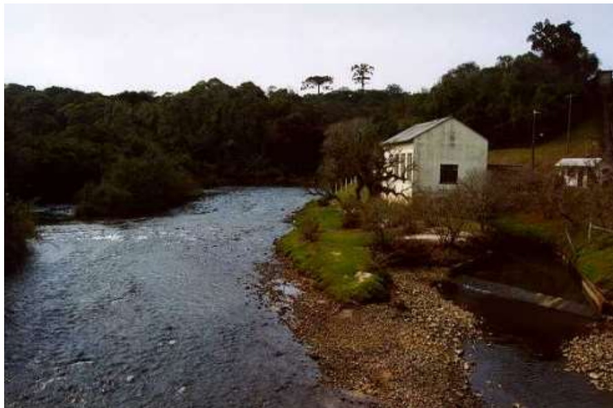
Figura 20: Usina Hidroelétrica Salto do Vau
