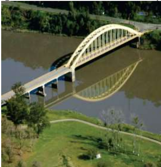
Ponte do Arco (Ponte Manoel Ribas).
