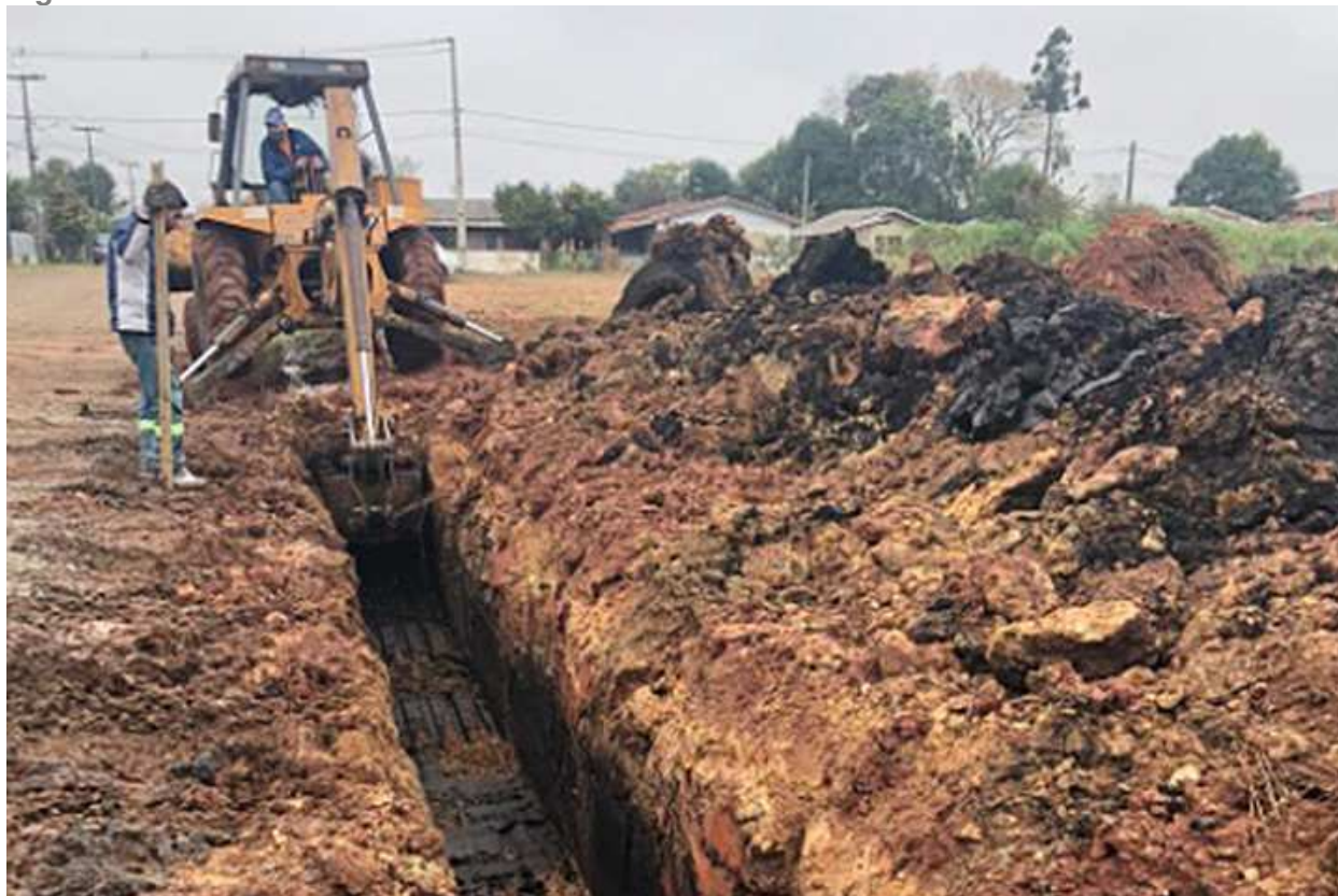
Figura 30: Obras na rua Eurico Cleto da Silva.
