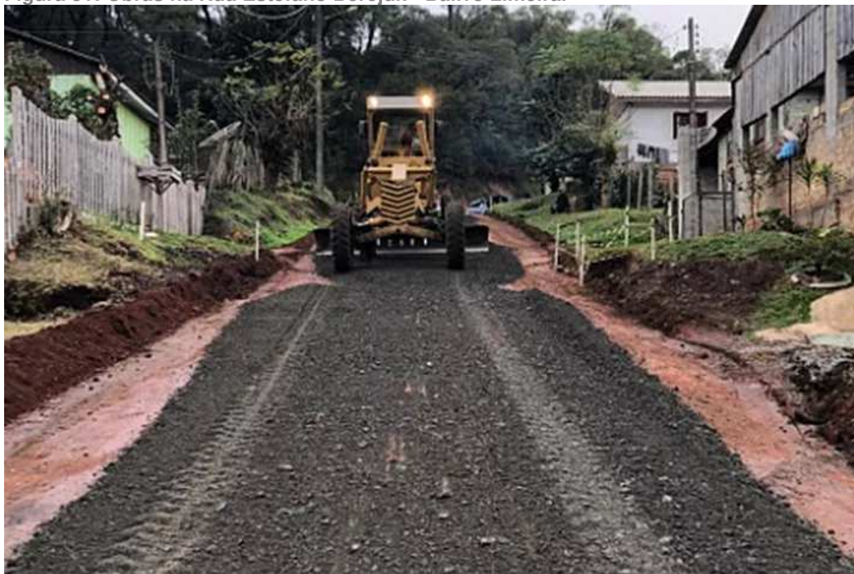
Figura 31: Obras na Rua Estefano Berejuk - Bairro Limeira.
