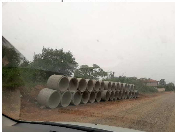
Figura 19: Manilhas que compõem as galerias subterrâneas pluviais urbanas.
