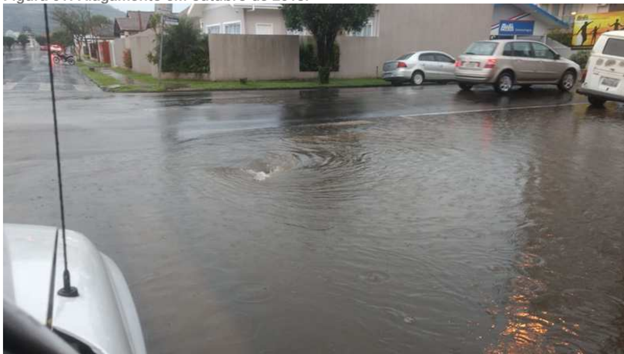
Figura 61: Alagamento em outubro de 2018.
