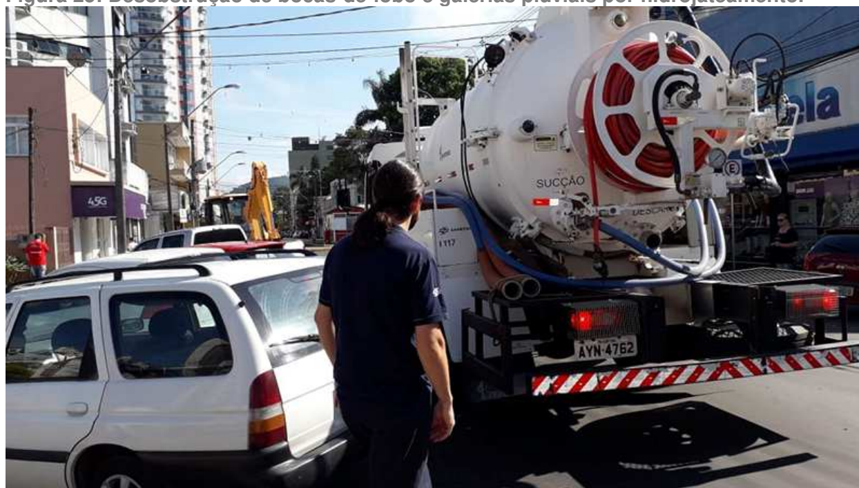
Figura 25: Desobstrução de bocas-de-lobo e galerias pluviais por hidrojateamento.
