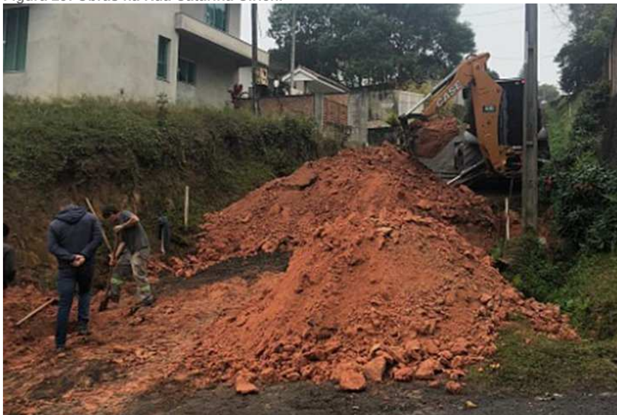
Figura 29: Obras na Rua Catarina Ulrich.
