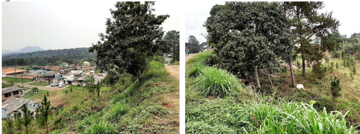
Figura 66: Desmoronamento no Bairro São Sebastião
