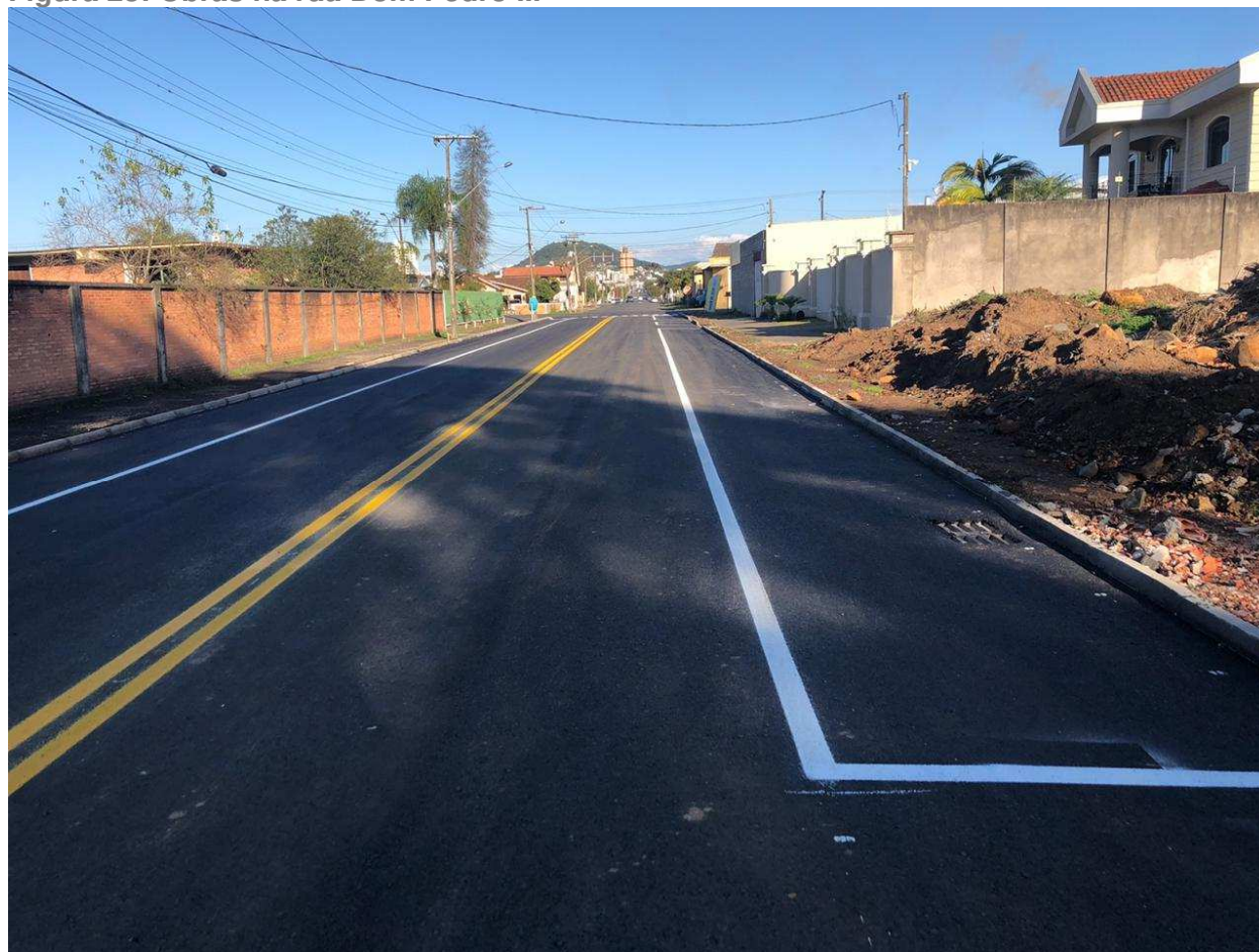
Figura 28: Obras na rua Dom Pedro II.
