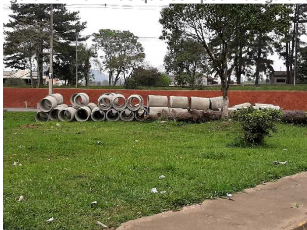
Figura 19: Manilhas que compõem as galerias subterrâneas pluviais urbanas.
