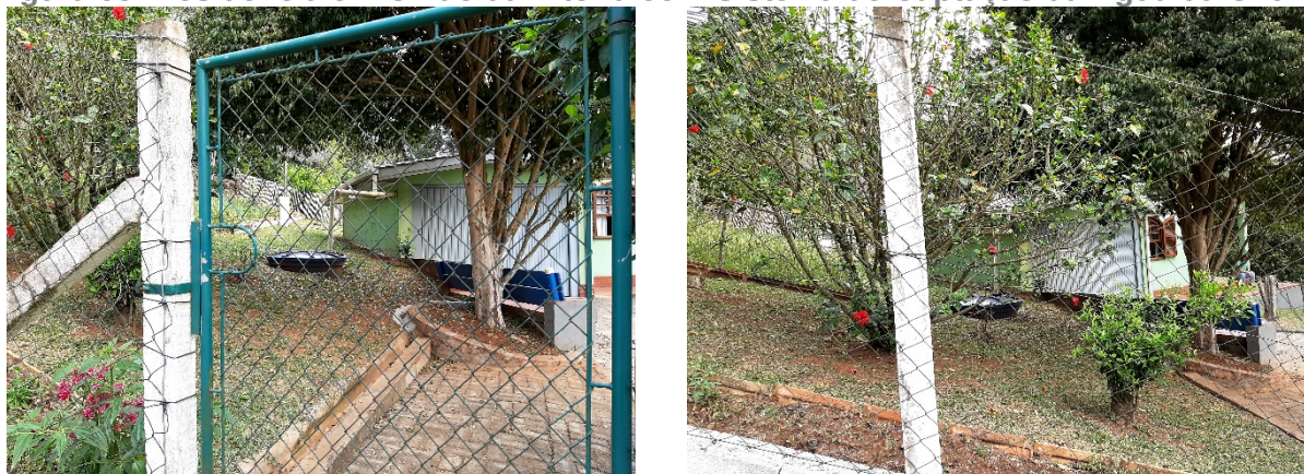
Figura 68: Residência em União da Vitória com Sistema de Captação da Água da Chuva.
