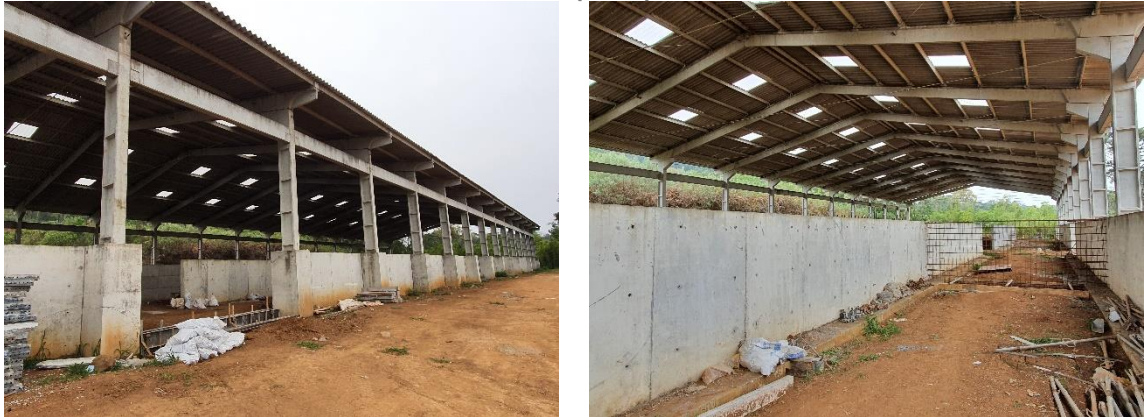
Figura 50: Unidade de Gerenciamento de Lodo (UGL).
