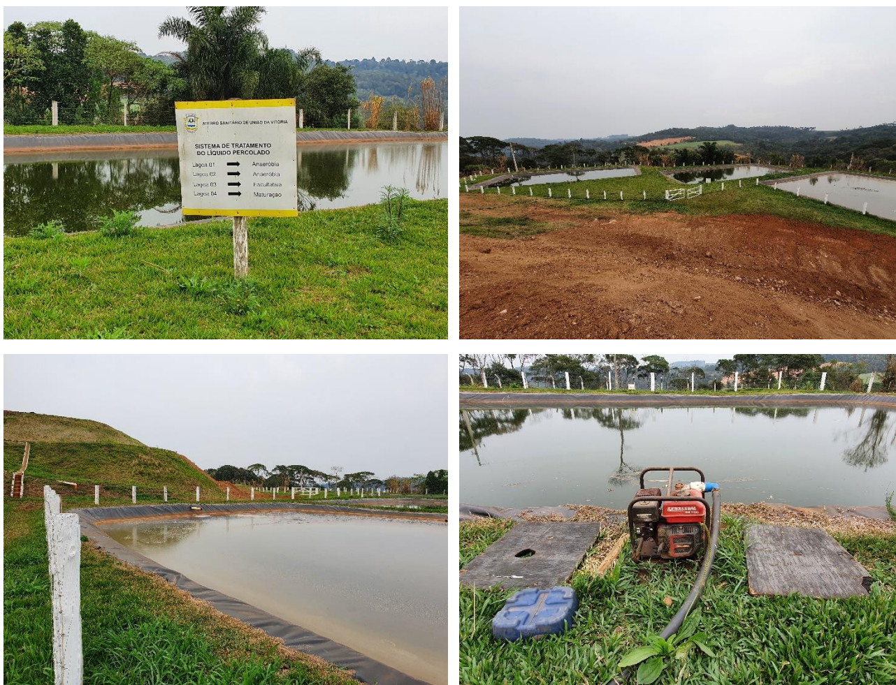
Figura 38: Lagoas de tratamento.
