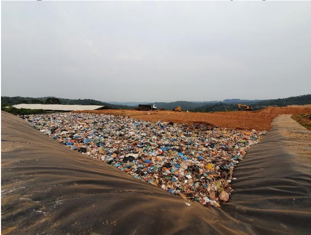
Figura 36: Aterro área 01 em operação.
