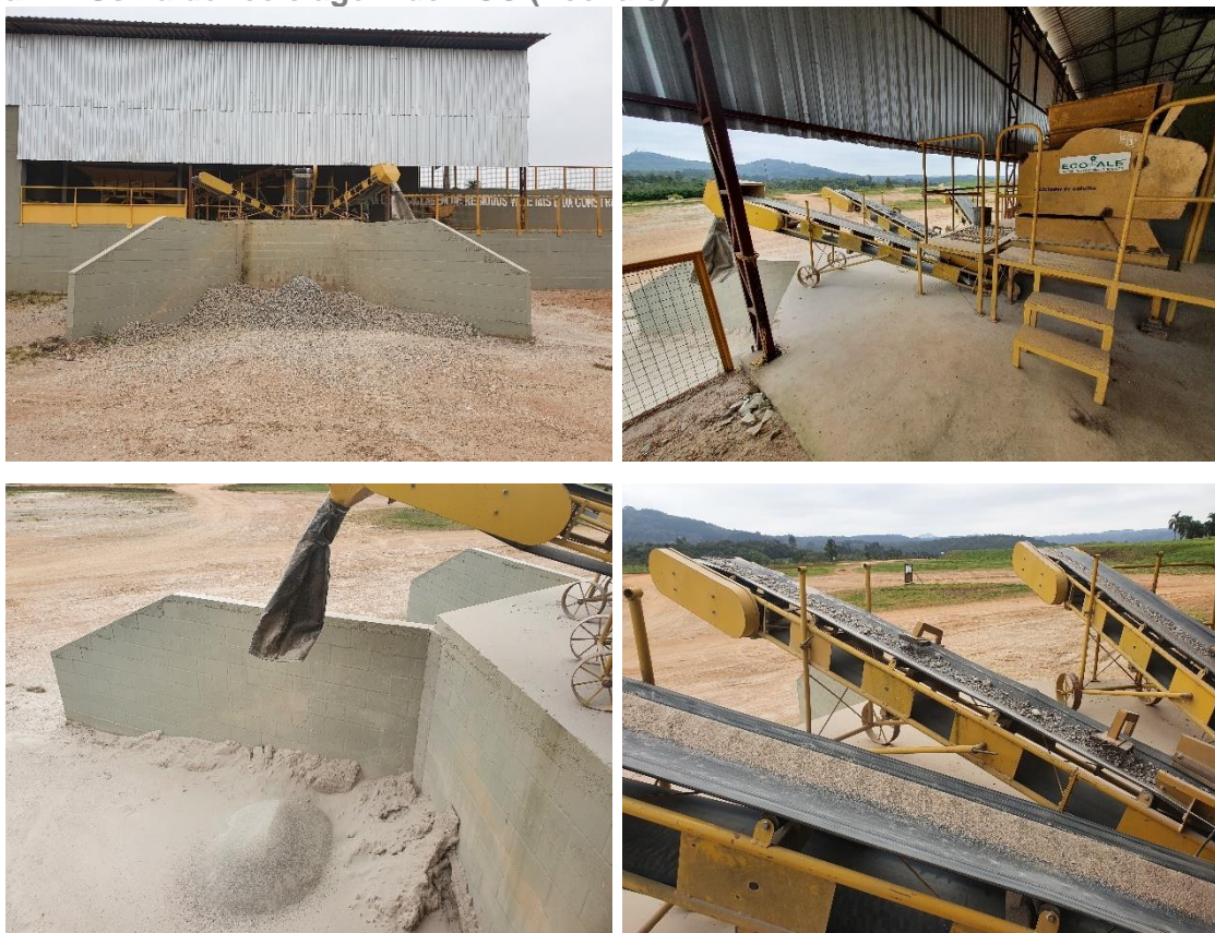
Figura 47: Usina de reciclagem de RCC (Ecovale).
