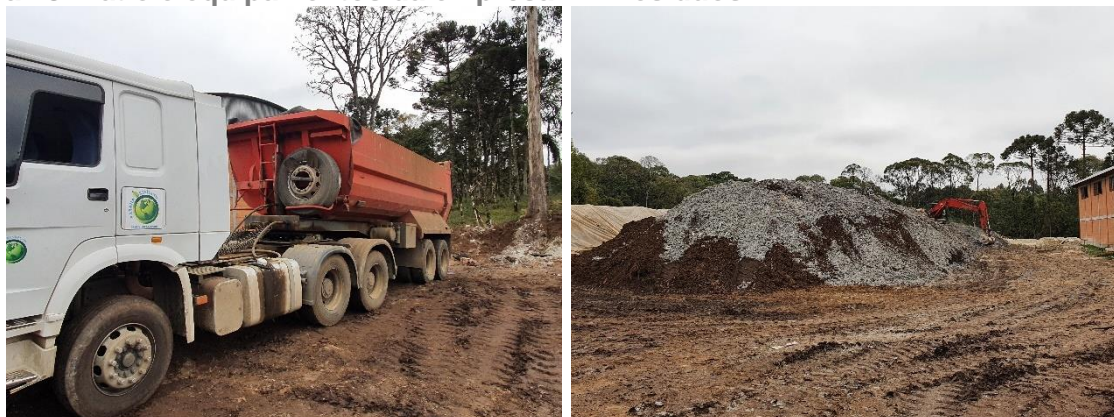
Figura 48: Pátio e equipamentos da empresa PR Resíduos.
