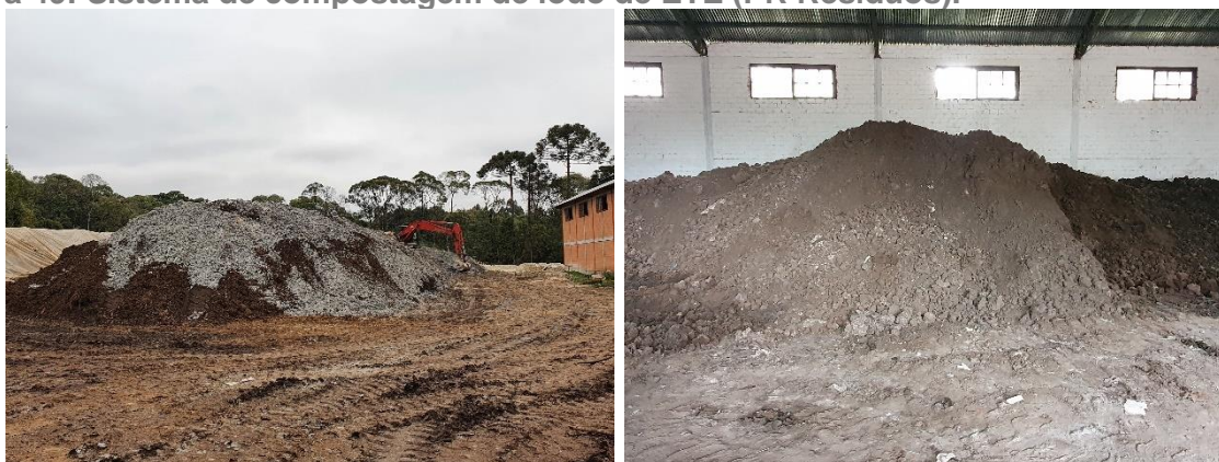
Figura 49: Sistema de compostagem de lodo de ETE (PR Resíduos).
