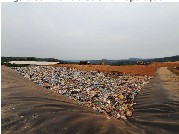
Figura 36: Aterro área 01 em operação.
