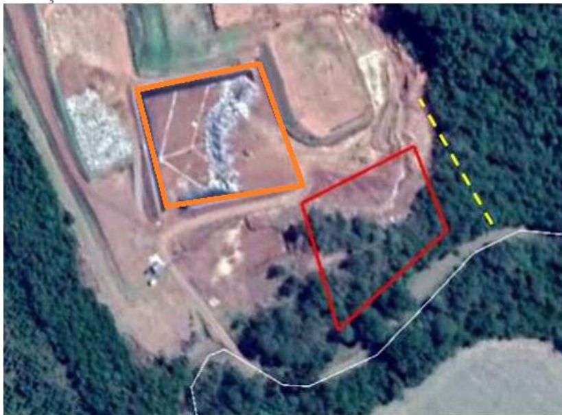
Figura 33: Demarcação de área da célula 01 e 02.
