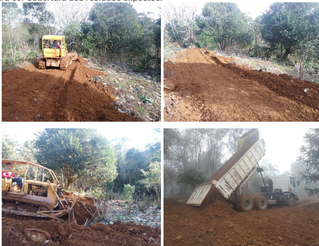
Figura 60: Cobertura dos resíduos expostos.
