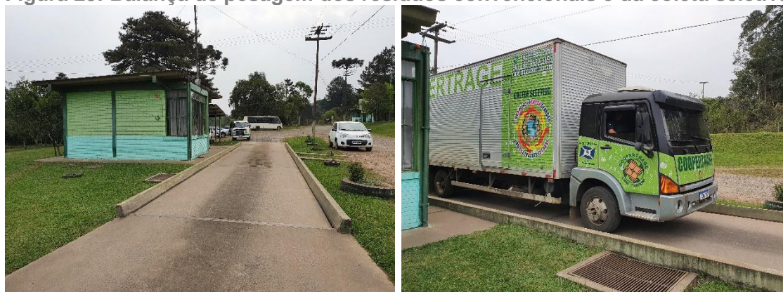
Figura 25: Balança de pesagem dos resíduos convencionais e da coleta seletiva.
