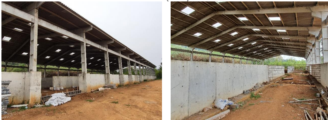
Figura 50: Unidade de Gerenciamento de Lodo (UGL).
