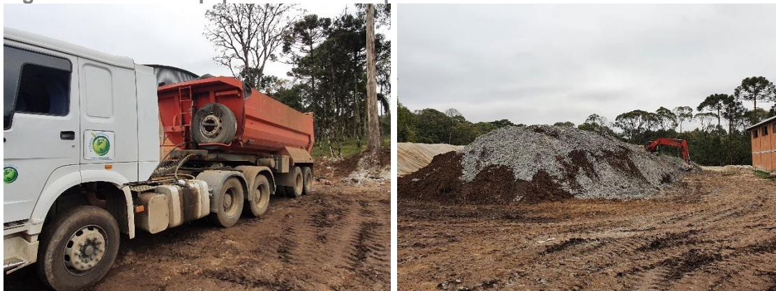
Figura 48: Pátio e equipamentos da empresa PR Resíduos.
