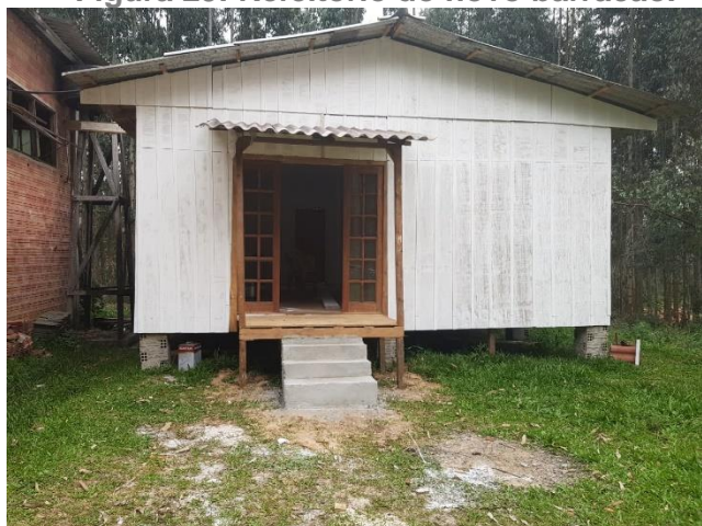
Figura 29: Refeitório do novo barracão.
